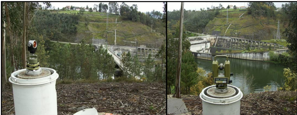
Figura 1 – A encosta da margem esquerda, vista dos pilares PM (à esquerda) e PJ (à direita)
