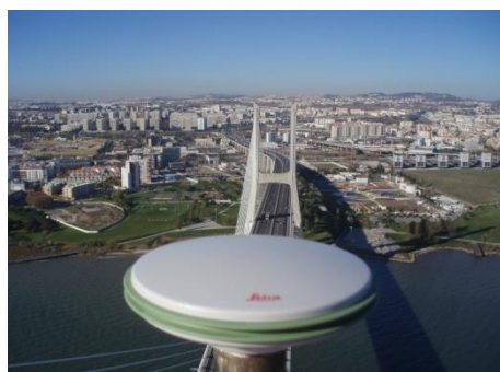
Figura 1- Antena GNSS, Torre Sul
