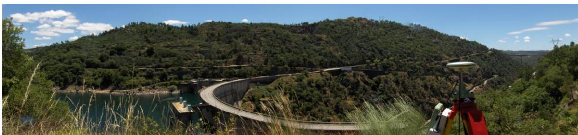
Figura 4 – Barragem do Cabril: estação GNSS LEICA
