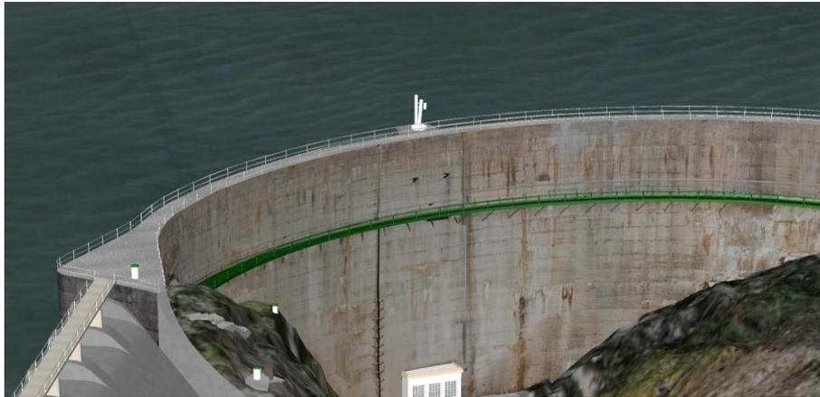
Figura 2 – Barragem do Alto Ceira: imagem obtida por varrimento *laser* 3D (equipamento “*laser scanner*” apresentado na Figura 3)
