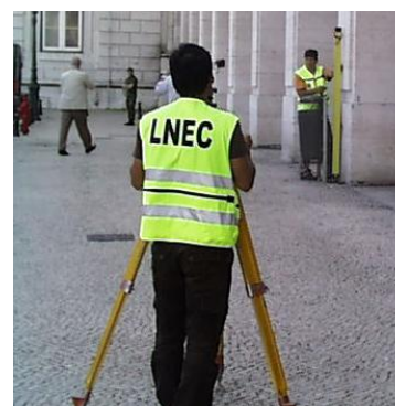
Figura 7 – Leitura para a mira estacionada no ponto 6
